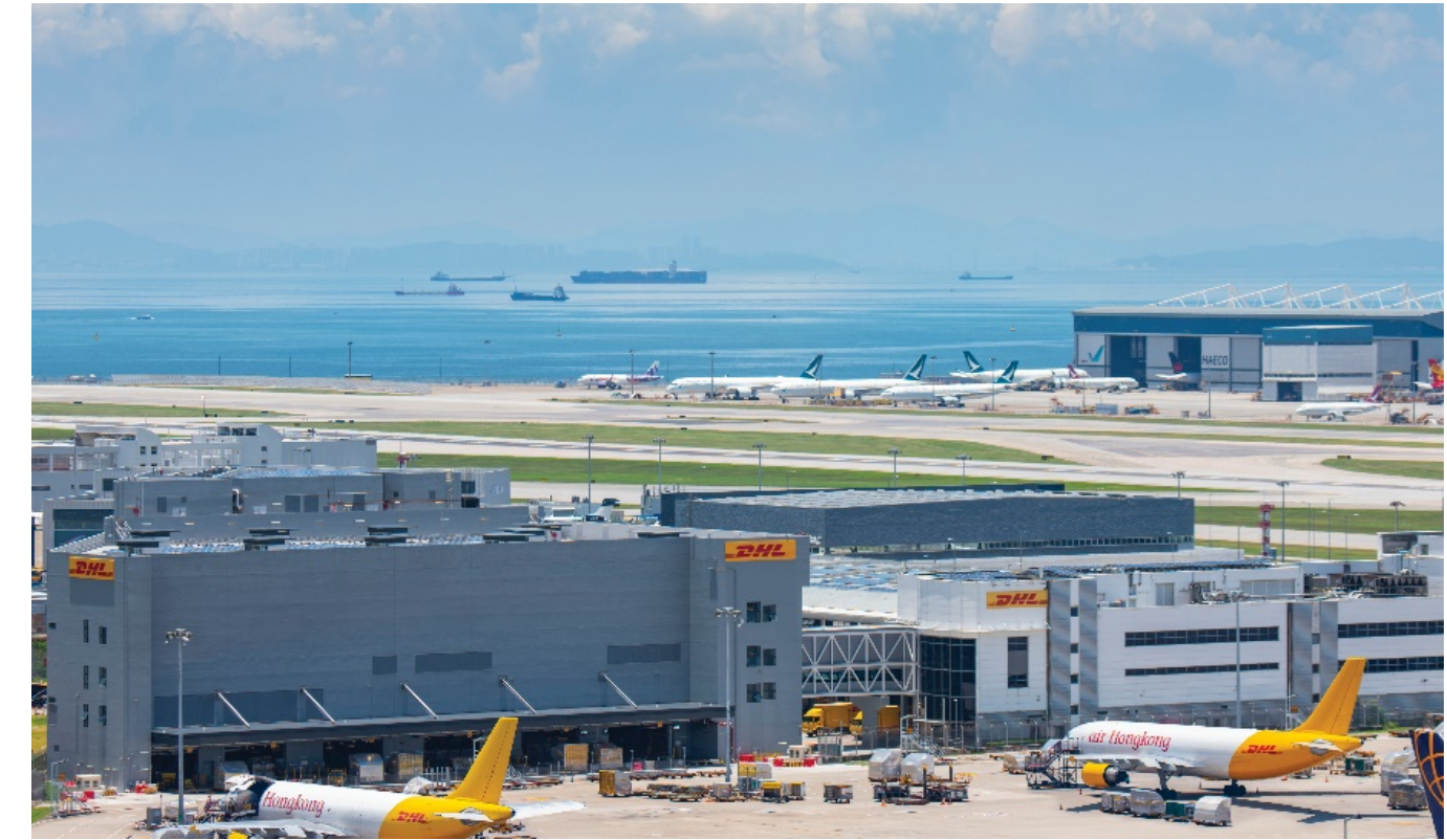
敦豪中亞樞紐中心擴建工程
