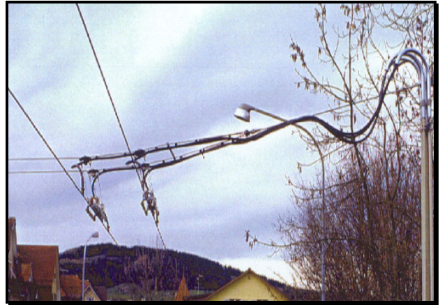
圖四 電線掣用以接駁電流往架空電纜以運作無軌電車。 (Furrer + Frey AG)
