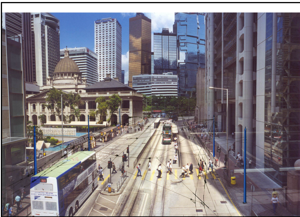
圖七 這圖展示在德輔道中的架空電纜及牽引柱，此由太子大廈行人天橋望向立法會大樓。 (背景照片： Barnaby P. Smith )
