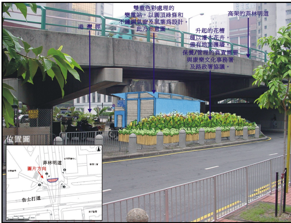
圖六 這圖展示位於菲林明道天橋底的牽引性變電站外貌。 (背景照片： Townland Consultants Limited )
